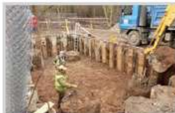
Odtěžení zeminy v místě základu pro pylon lávky na káranské straně. Foto: archiv ORM
